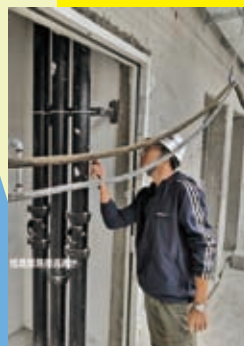
检查管道是否漏水
